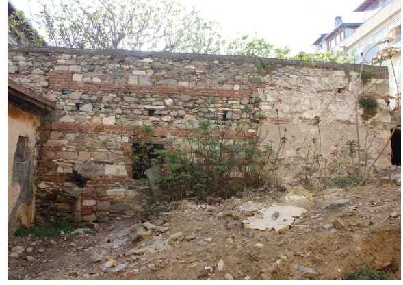
Fig. 3: Doğu cephenin görünümü
