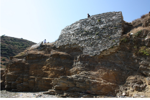
Fig. 2: Doğu duvarının kuzey bölümü
