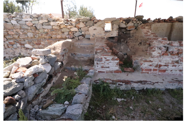
Fig. 10: Merdiven ve ocak
