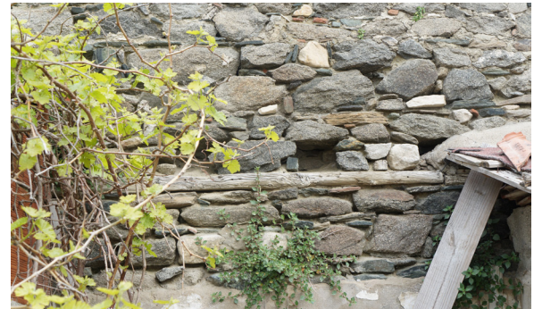
Fig. 3: Kuzey duvardaki ahşap yastık kirişi ve kiriş yuvaları (2019)
