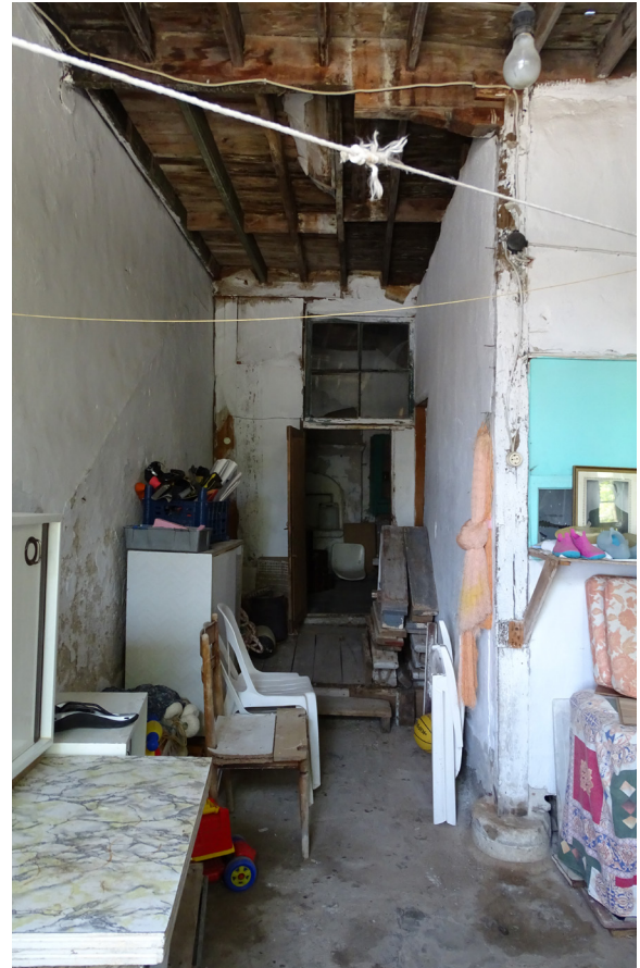
Fig. 5: Zemin kat taşlık mekânı
