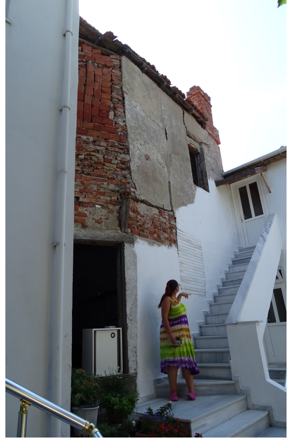
Fig. 4: Yapının kuzey cephesinden sağlanan giriş ve tuğla duvar
