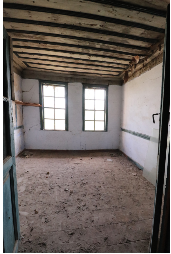
Fig. 6: Birinci kat güneydoğudaki oda
