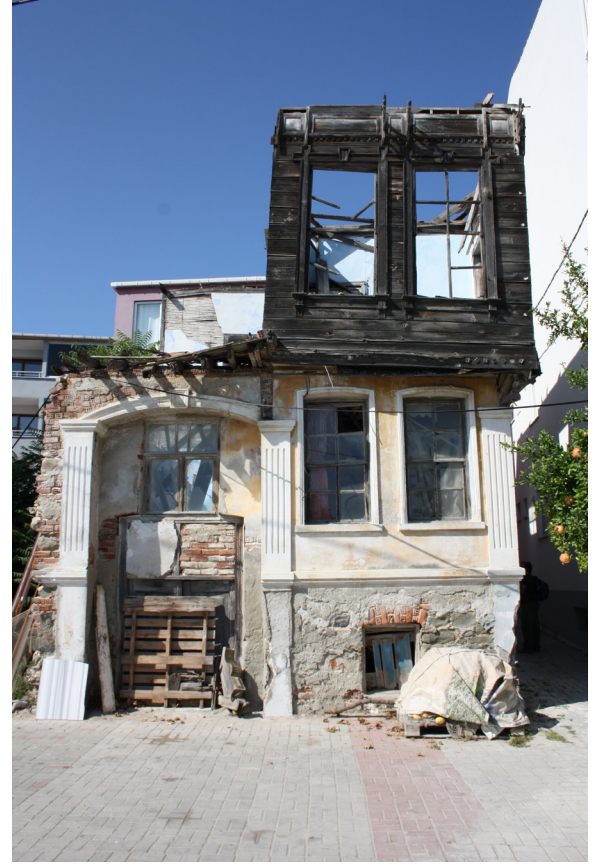
Fig. 2: Güney cephe, genel görünüm
