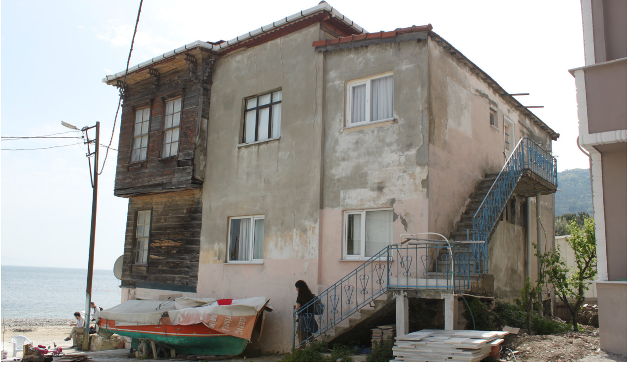
Fig. 2: Doğu cephe ve kuzeydeki betonarme ek
