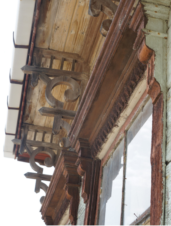
Fig. 4: Saçak konsol detayı
