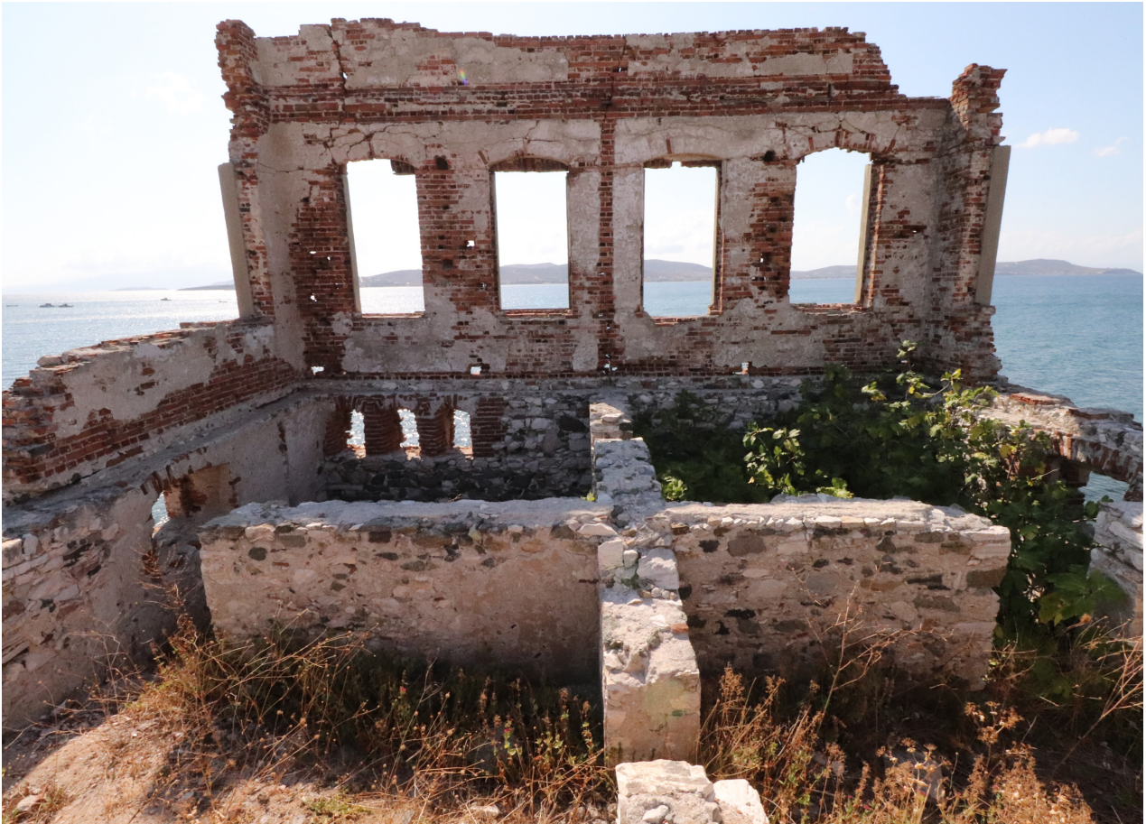
Fig. 2: Bodrum kat ara duvarlar ve zemin katın güney duvarı, kuzeyden görünüm
