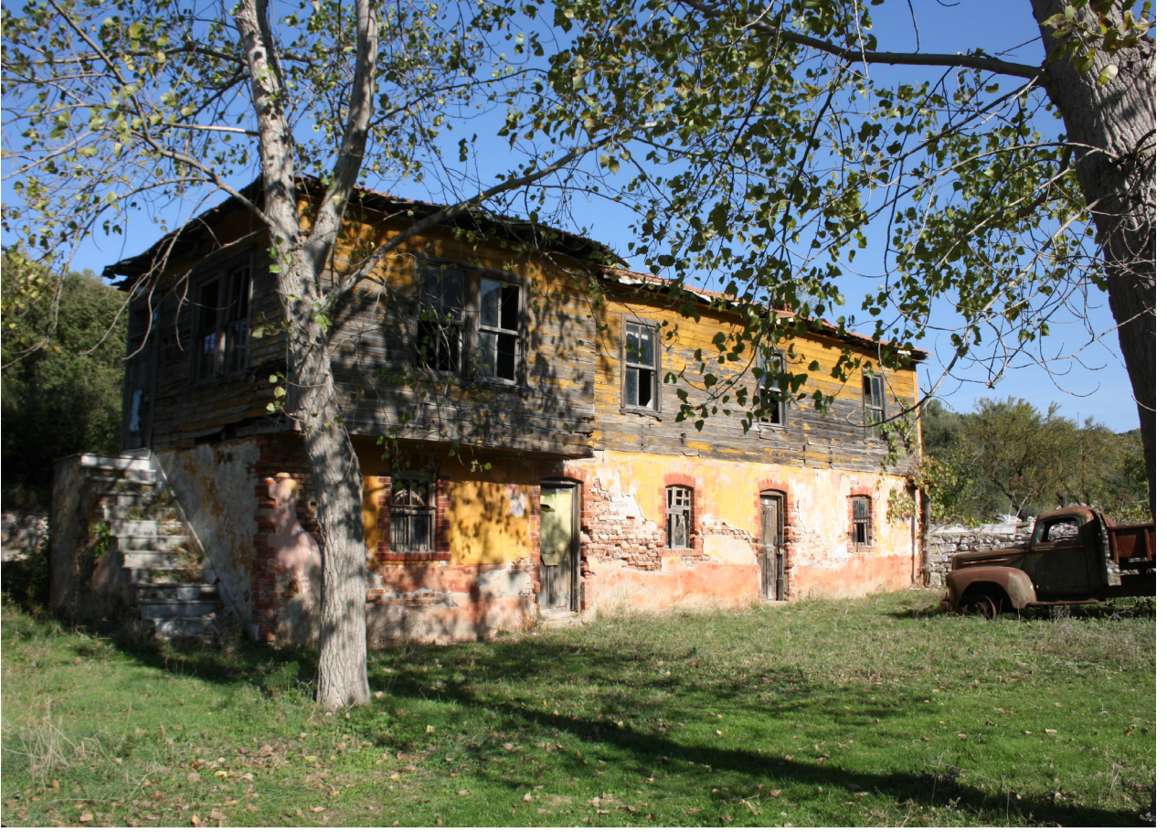
Fig. 2: İdari bina güney ve batı cephelerin genel görünümü
