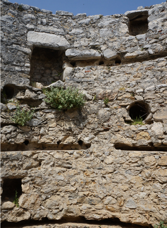
Fig. 5: Saraylar Kuzey Değirmen, iç mekan
