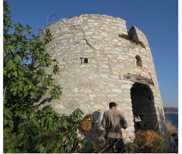
Fig. 9: Ekinlik Değirmen 3, batı cephesi ve genel görünüm
