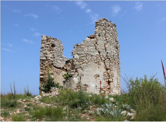
Fig. 4: Saraylar Güney Değirmen, genel görünüm
